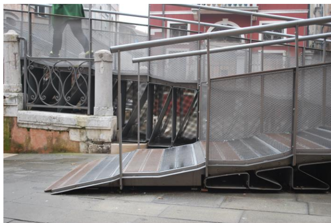
Figura 1. Ponte d'Ognissanti, Venezia. Particolare della rampa con "Gradino agevolato". Progetto di David Zannoner. (Antonio Lauria)
